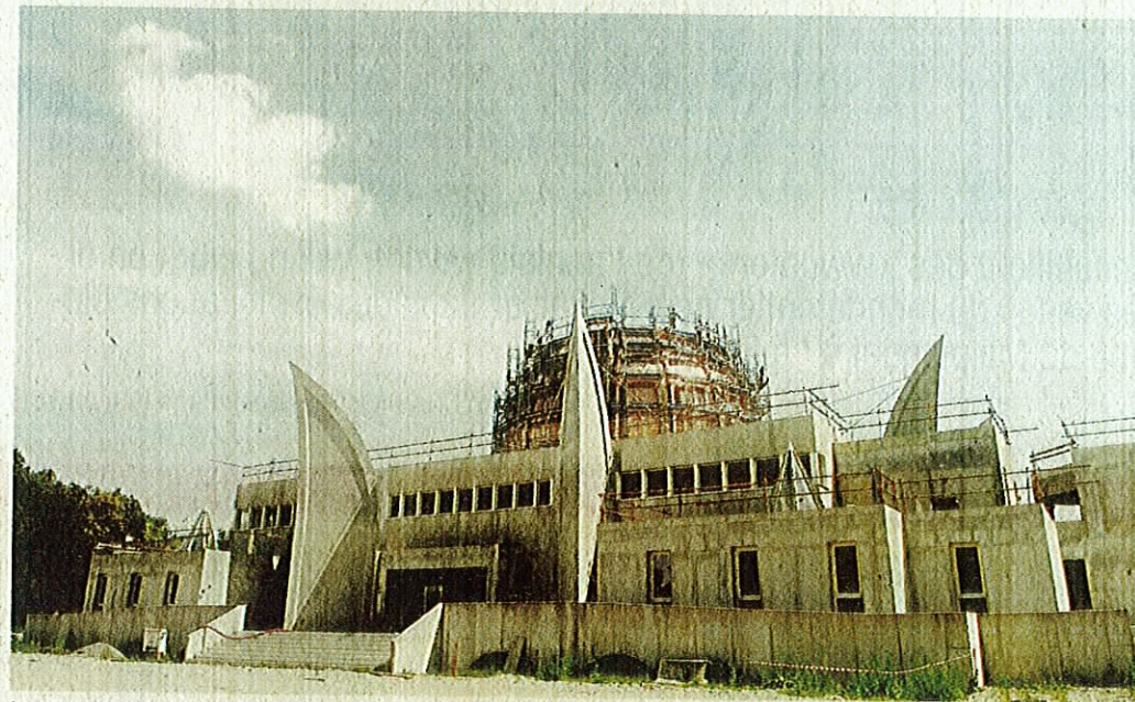
Le chantier de la Grande mosquée de Strasbourg. (Photo DNA-Cédric Joubert)
